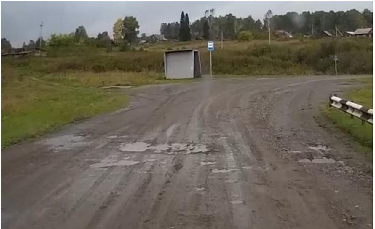
Рисунок 5.6 – Дефекты дорожного покрытия (выбоины), д. Копылово
