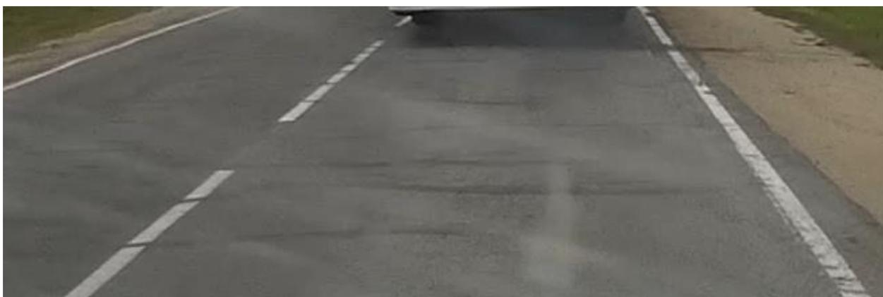
Рисунок 5.1 – Дефекты дорожного покрытия (залитые трещины), с. Поперечное
