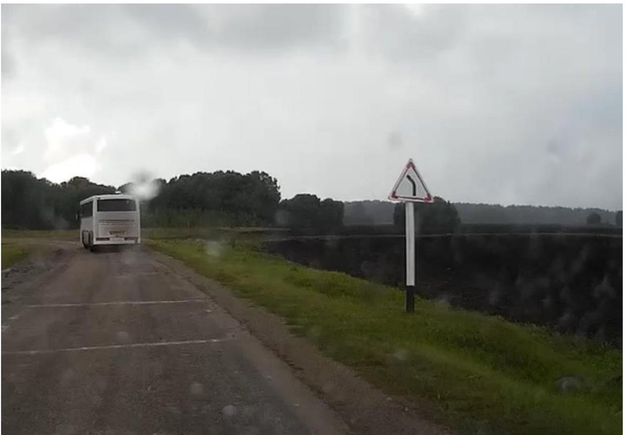
Рисунок 5.8 – Потеря световозвращающей способности и яркости дорожного знака 1.11.2, отсутствие дорожной разметки, а/д «Подъезд к п. Сокольники»
