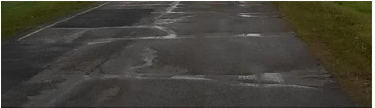
Рисунок 5.3 – Дефекты дорожного покрытия (неровность ямочного ремонта), д. Милютино
