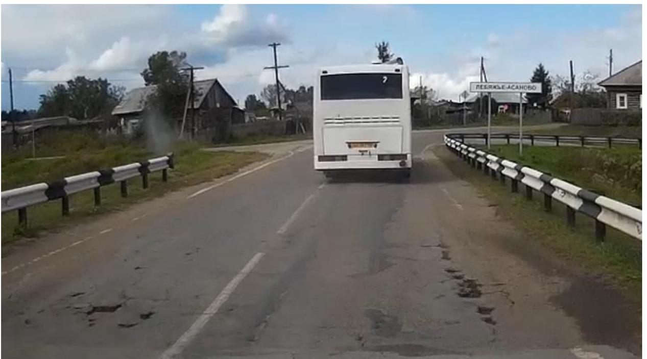
Рисунок 5.5 – Дефекты дорожного покрытия (выбоины, залитые трещины), д. Лебяжье-Асаново
