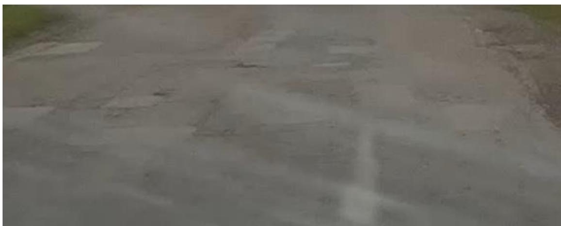
Рисунок 5.2 – Дефекты дорожного покрытия (карта заделанных выбоин), с. Поперечное
