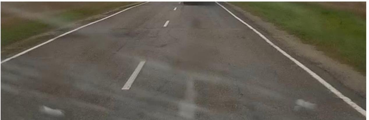
Рисунок 5.4 – Дефекты дорожного покрытия (износ дорожного покрытия, продольные трещины, поперечные трещины), а/д «Новосибирск – Иркутск – п./ст. Арлюк с подъездок к п. Линейный»
